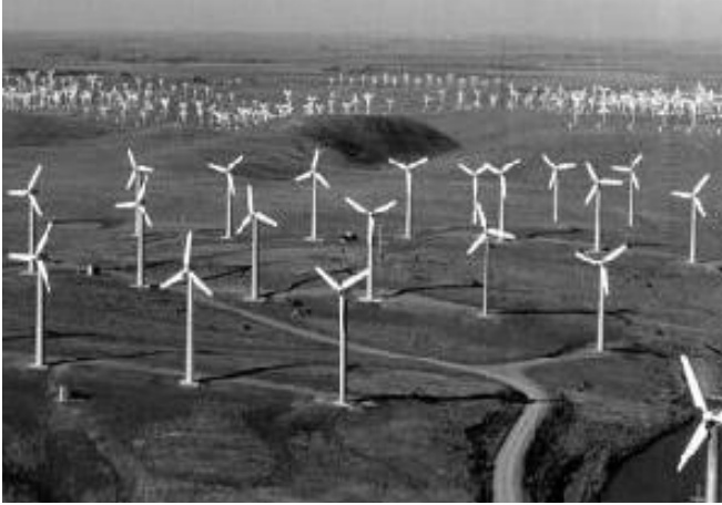
Se estima que para el año 2020 podrían instalarse 1.2 millones de MW de capacidad eólica mundialmente.
