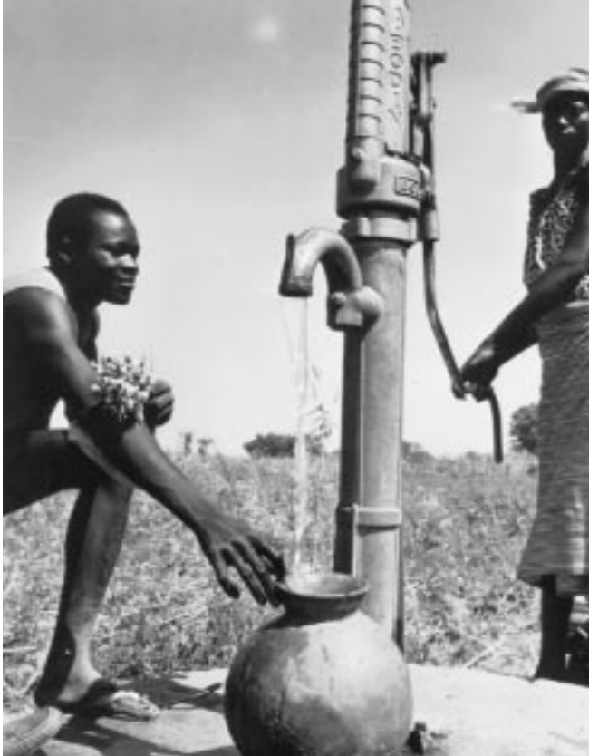
Pompage de l'eau au Burkina Faso
