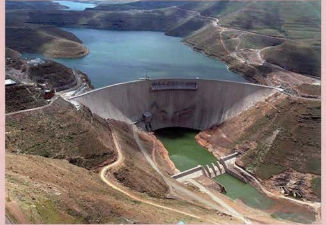
Inga 3 Dam, DRC
