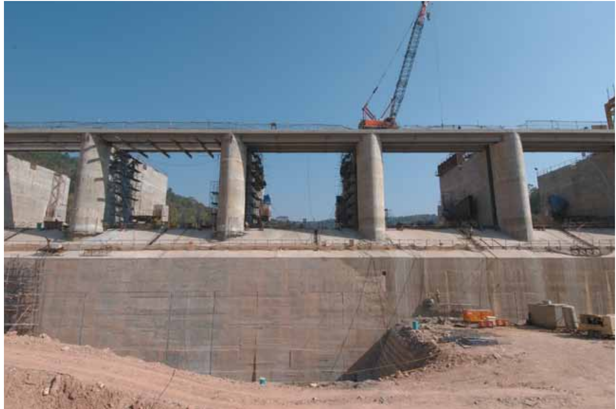
ປະຕູລະບາຍນໍ້າຈາກເຂື່ອນ ກຳລັງຢູ່ໃນໄລຍະກໍ່ສ້າງເຂື່ອນນໍ້າເທີນ 2: ພາບໂດຍ Marcus Rhineland
