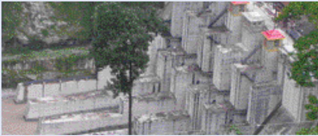
Construcción de la Represa de Teesta V, Sikkim, India, 2008. Fotografía de Samir Mehta, International Rivers.
