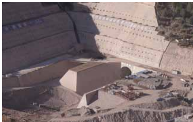
2012年10月，建设中的黄登大坝。 照片提供：国际河流
