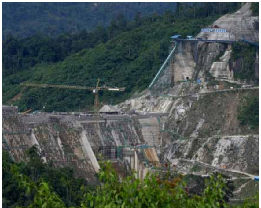
2012年5月，沐若大坝工程接近完工。
