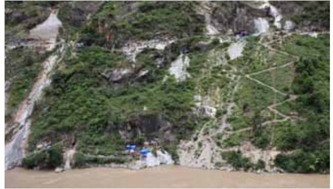
2011年6月，怒江岸边为修建怒江松塔大坝而准备的施工道路及简易工棚。照片提供：绿家园志愿者
