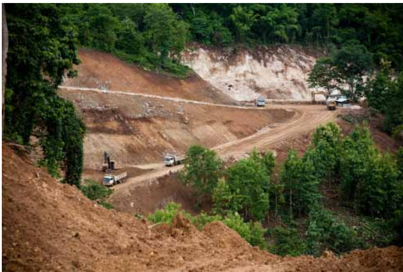
为沙耶武里(Xayaburi Dam)水坝工程修路。
